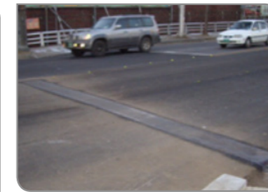
개선공법의 공용 중 전경
