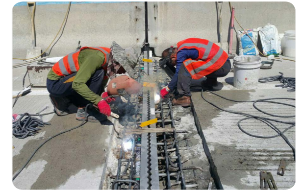
신축이음 거치 및 보강철근 용접
