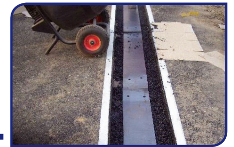
4 고무시트 및 지지판 설치
