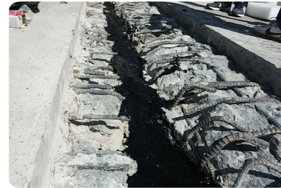
블럭아웃 및 유간 방수재 포설
