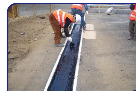
5 2차 탄성폴리머 코팅 후 유공관 설치
