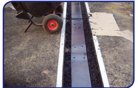
고무시트 및 지지판 설치 4
