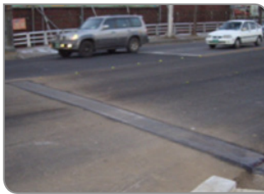
개선공법의 공용 중 전경
